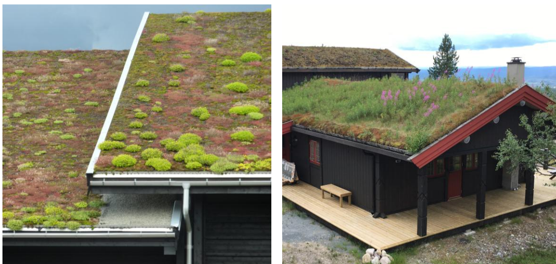
Figur 25. Två exempel på byggnader med gröna tak. Foto: WRS.
