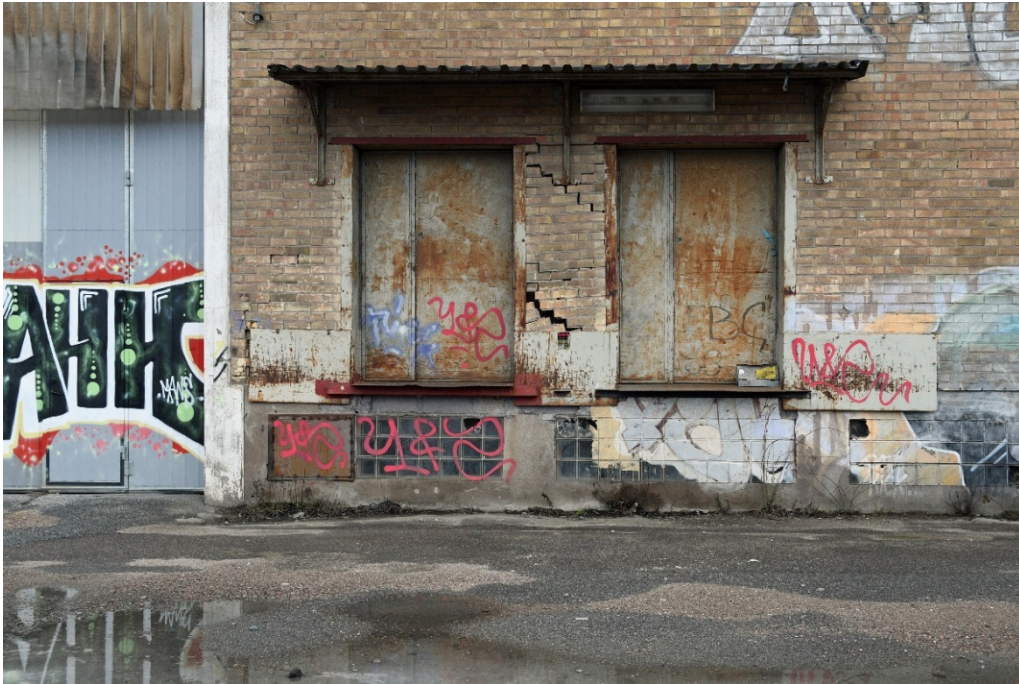
Bild 25 De två portarna mitt på byggnaden är sekundära. Väggen med gult fasadtegel är inte bärande utan består av ett inre och ett yttre skikt av fasadtegel med mineralull som isolering mellan skikten. Det är inte förvånande att väggpelaren mellan portarna har sprickor.
