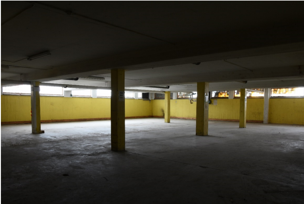
Bild 30 Källare under den tillbyggnad som gjordes 1959 – 1966, med betongbjälklag som bärs upp av pelare och ljusinsläpp från betongglaspartier.
