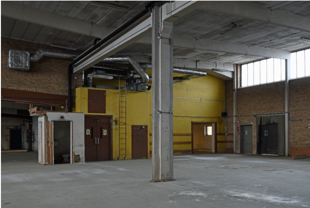
Bild 40 Lagerhallens vägg mot den äldre byggnaden.
