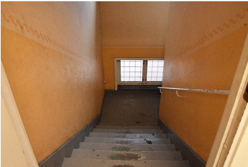
Bild 51 Trappa från övervåningen till bottenvåningen.
