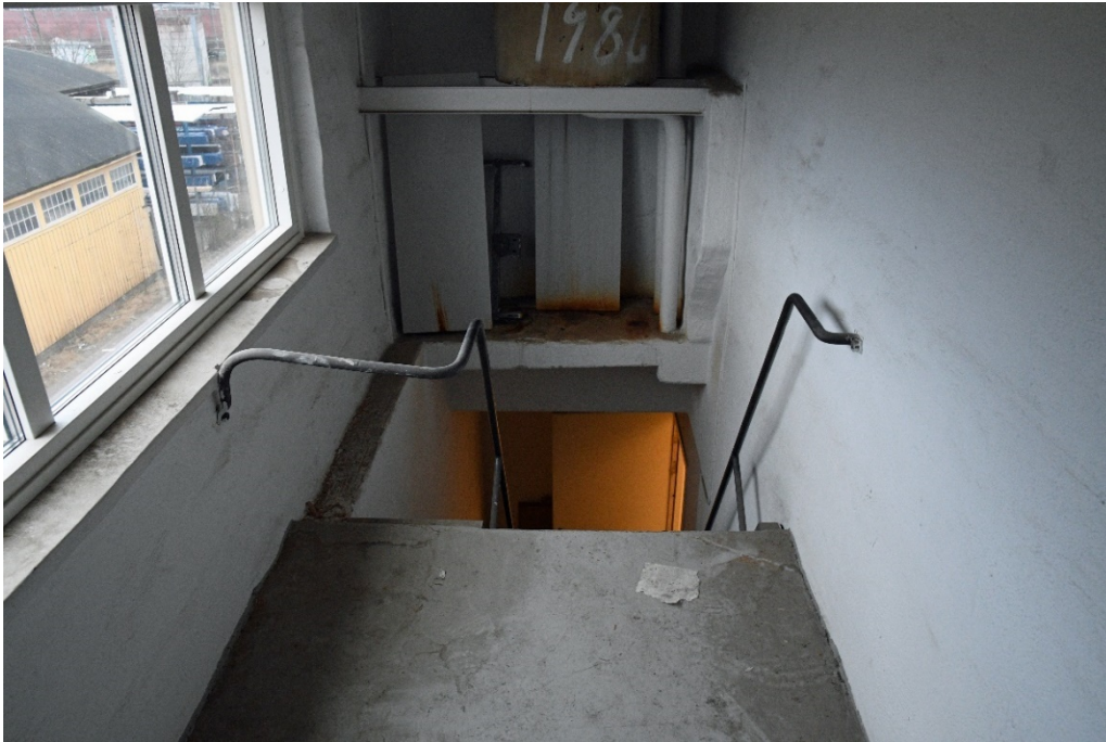
Bild 50 Det centralt placerade tornets översta våning med trappa ner till övervåningen. I tornet finns en hiss för transport av varor från källaren och upp genom byggnaden.
