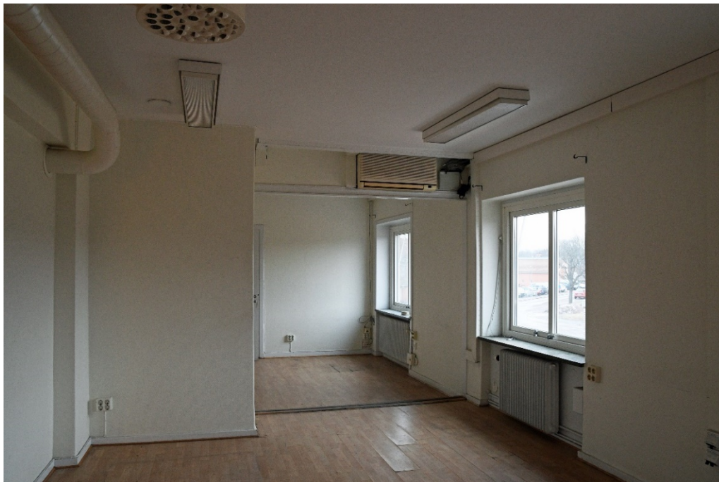
Bild 47 Utrymmet närmast i bild var ursprungligen ett lager men har senare byggts om till kontor. I samband med detta har skiljeväggen mot lägenhetens rum, längre bort i bilden, tagits bort.
