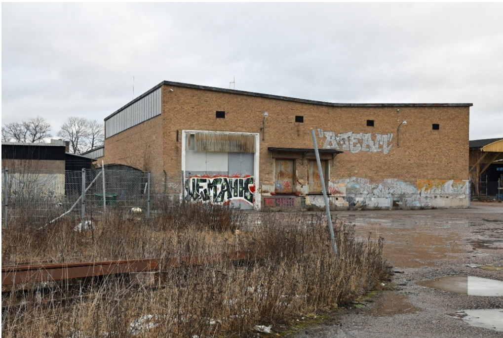
Bild 24 Gavel mot gårdssidan. Byggnaden har ett motfallstak, ett tidstypiskt utförande.
