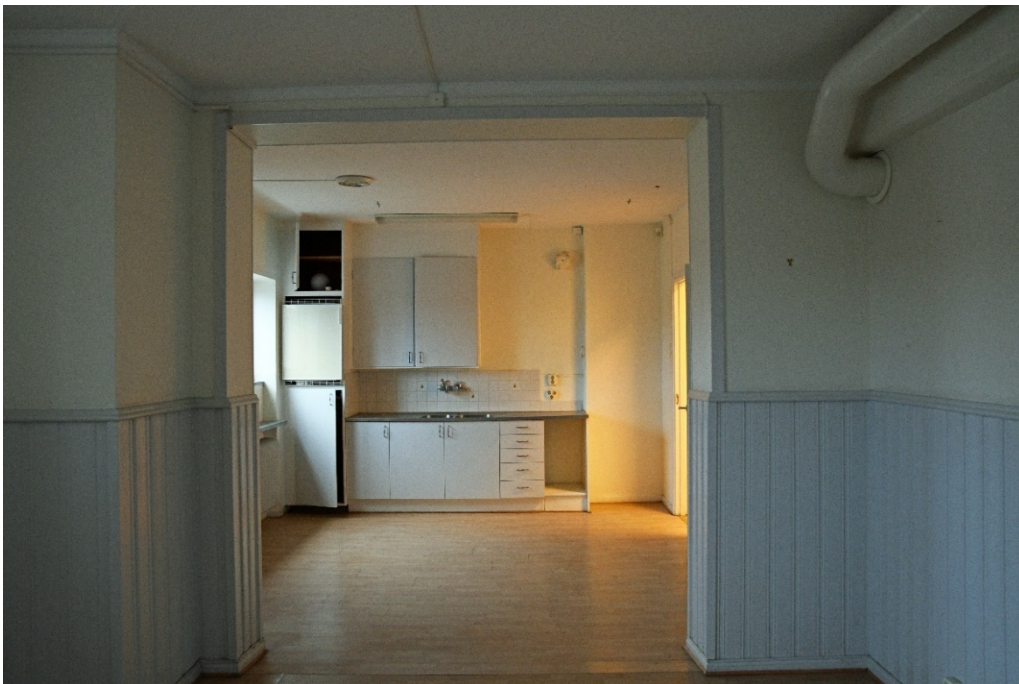
Bild 49 Ursprungligt personalrum med pentry med senare muröppning mot tidigare lagerhall.
