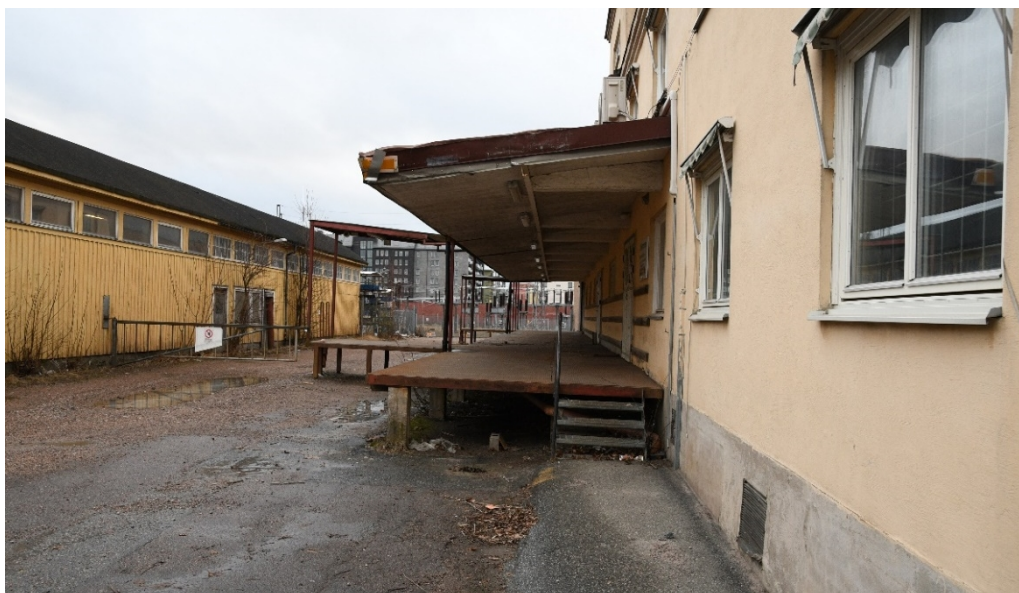
Bild 20 Lastrampens ursprungliga utsträckning syns genom de kraftiga bjälkändar som slutar ungefär vid halva takfallet.
