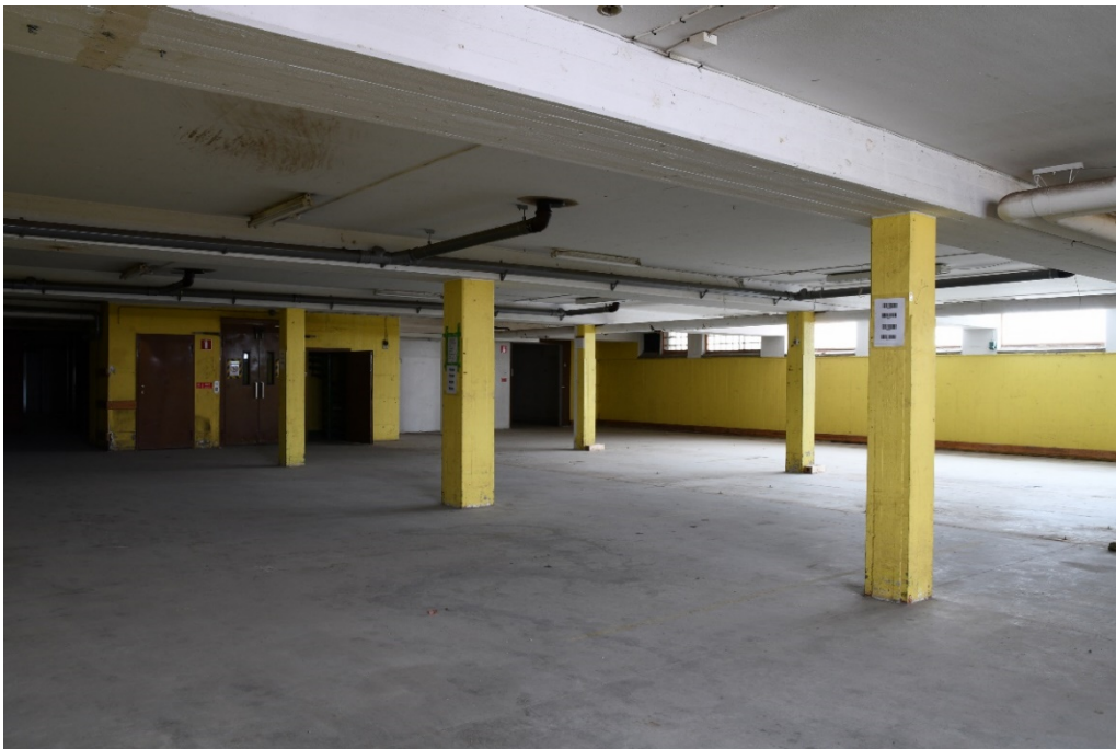
Bild 31 Vy från den nyare källaren mot den ursprungliga byggnadens källare.
