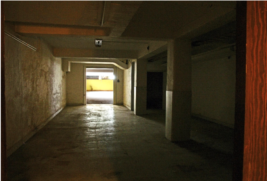
Bild 32 Den ursprungliga byggnadens källare med öppning mot den nya källaren. I det utrymme som syns på bilden fanns ursprungligen kylrum, på ömse sidor om mittgången till höger i bild om pelarna. Skiljeväggarna till de vänstra kylrummen har tagits bort men de finns kvar till de högra kylrummen.
