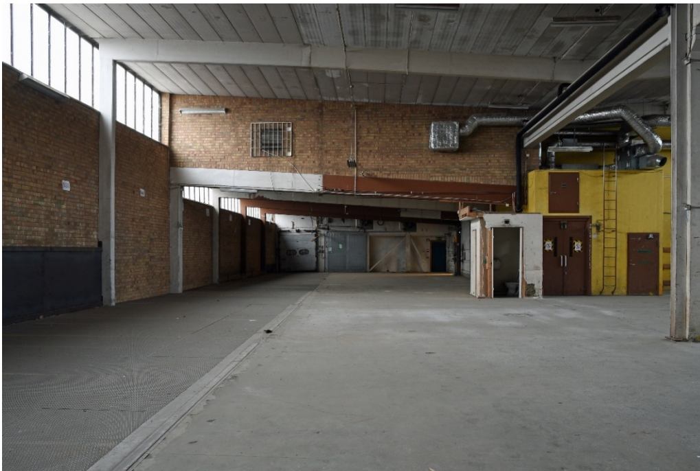
Bild 39 Lagerhall med hög- respektive lågdelen uppförd 1959 – 1966. Den borte väggen i lågdelen har portar mot en sentida tillbyggnad för en nerfartsramp till källaren.
