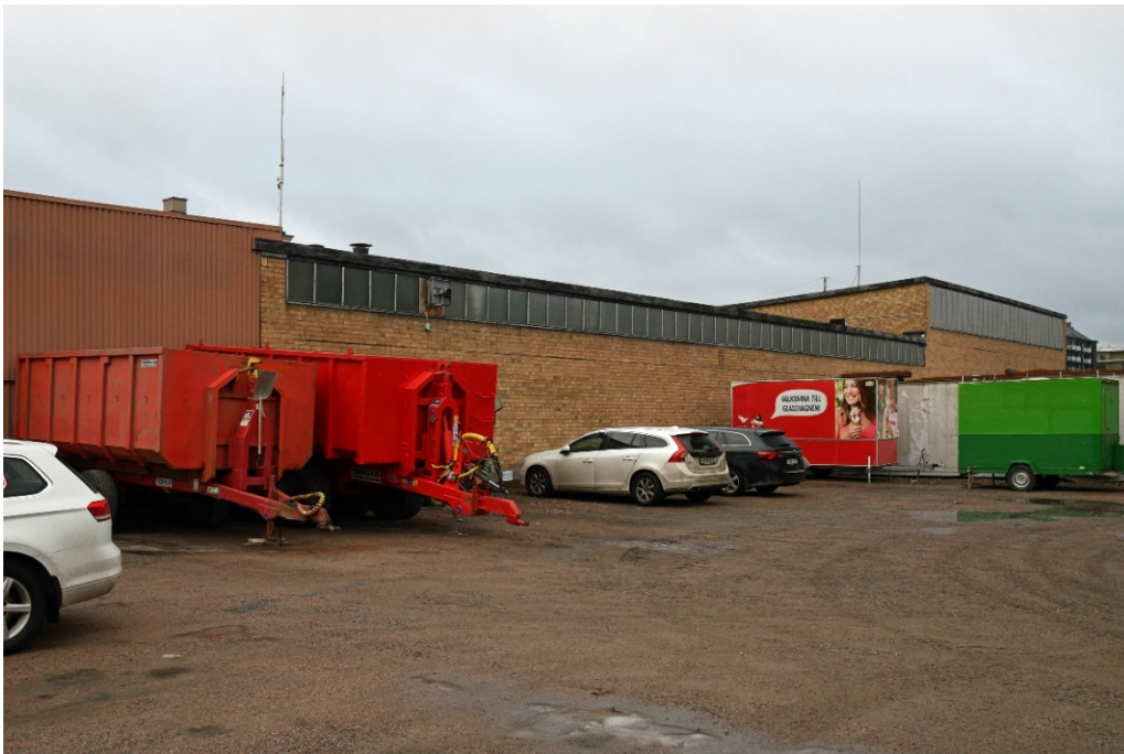
Bild 26 Tillbyggnadens fasad mot grannfastighetens parkeringsplats. Tillbyggnaden består dels av en högdal och dels en lågdal. Längst till vänster syns en senare byggnadsvolym med fasader av korrugerad plåt som inrymmer en nerfartsramp till källaren.
