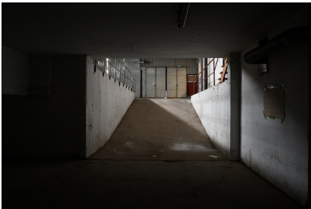
Bild 29 Vy från källaren mot porten från Säbygatan.
