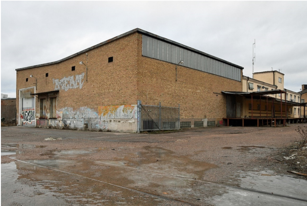
Bild 23 Vy över tillbyggnaden från gårdssidan. Tidigare löpte ett stickspår från stambanan in i porten till vänster i bild. Hela byggnadsvolymen innefattar ett stort och högt rum som får dagsljus från fönsterbanden vid takfoten. I sockeln finns ett motsvarande fönsterband av betongglas som ger ljus till källarvåningen.
