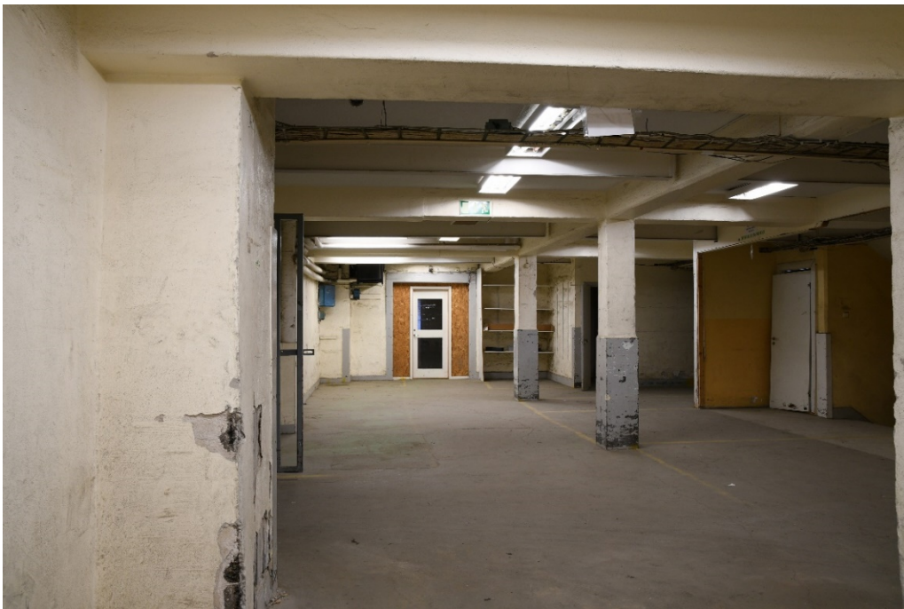
Bild 37 Lagerutrymmen i den äldre byggnadens källare.
