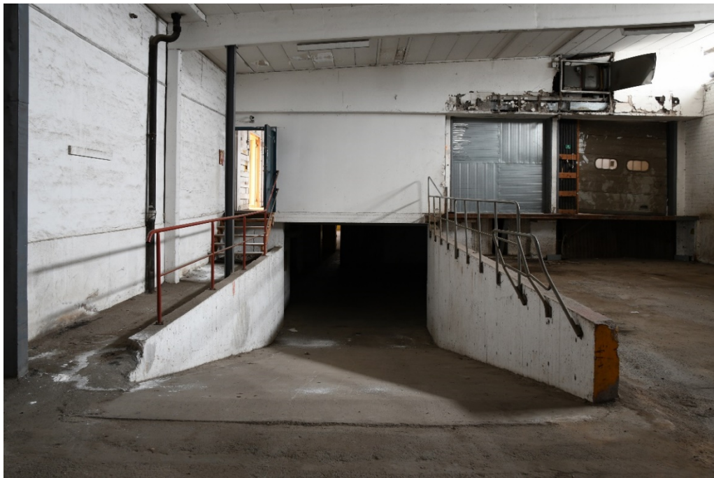
Bild 28 Nerfartsramp till den utvidgade källaren, troligen utförd under 1990-talet. Till vänster i bild syns den äldre byggnadens slammade yttervägg som nu byggts in.
