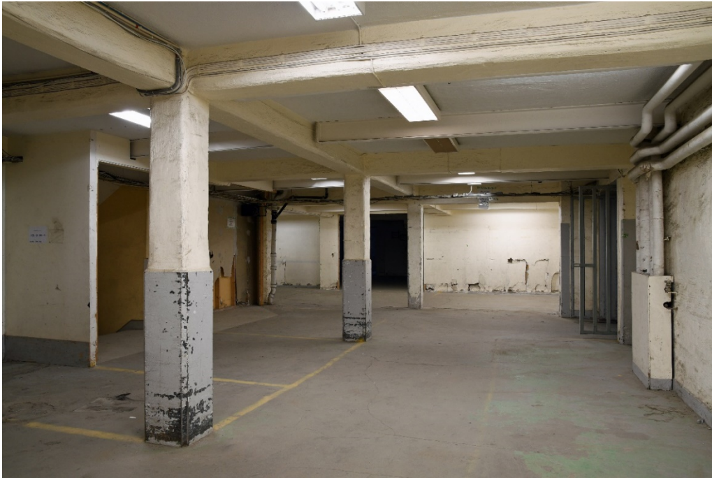
Bild 36 Större delen av bottenvåningen upptogs ursprungligen av lagerutrymmen och packrum. Lagerutrymmena, längs byggnadens nordvästra långsida, användes för rotfrukter och frukt och saknade därför fönster.
