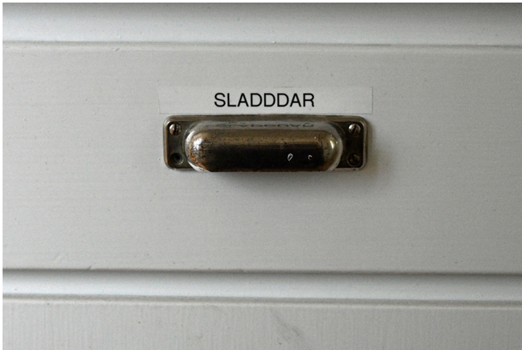
Bild 46 I byggnadens norra hörn fanns ursprungligen lägenhetens kök och en serveringsgång förband köket med bostadsrummen. Ursprunglig skåpsinredning finns kvar i serveringsgången men köket har tagits bort i samband med att lägenheten byggdes om till kontor.
