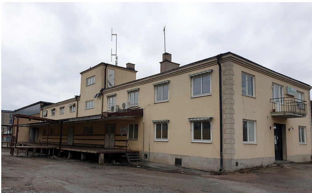
Bild 15 Boländerna 10:3, sedd från Säbygatan.
