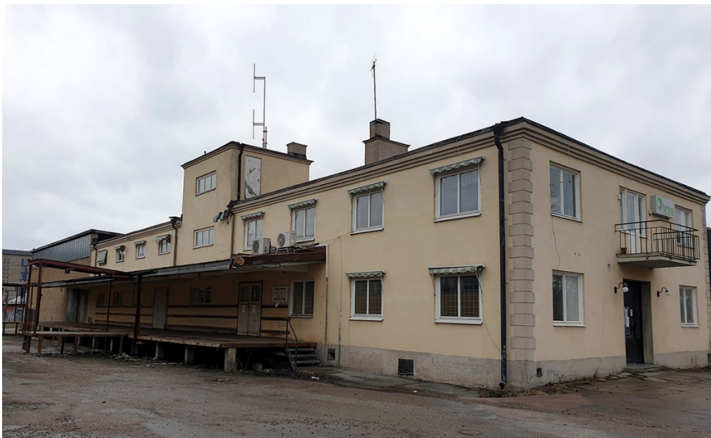
Bild 15 Boländerna 10:3, sedd från Säbygatan.
