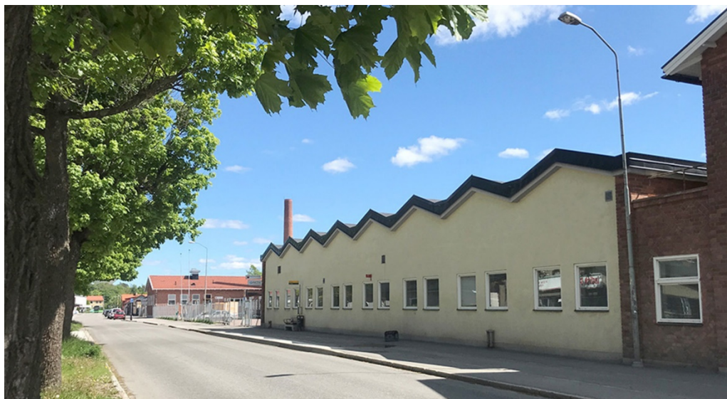
Bild 11 Söderbergiska huset. Fasad mot Bergsbrunnagatan. Det sågtandade taket.
