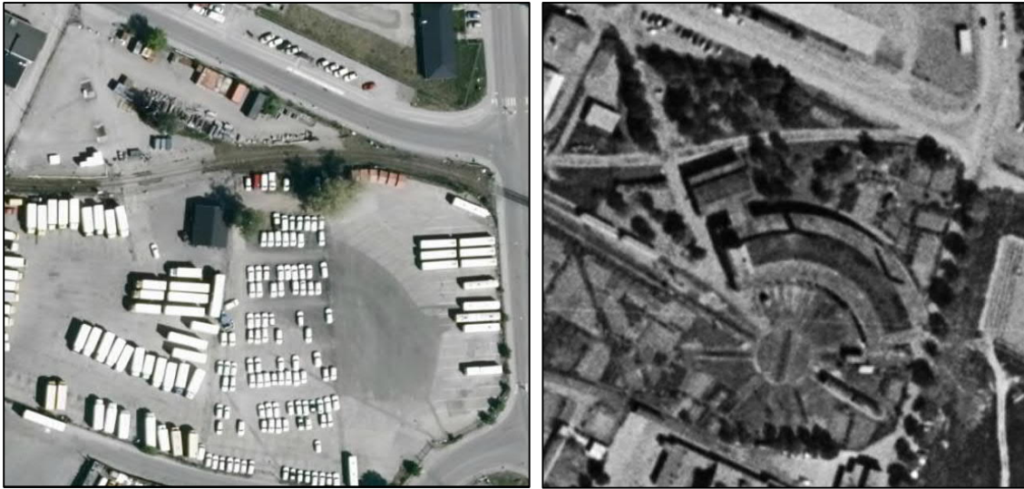
Figur 21, Flygfoto/historiskt flygfoto över fastigheten Boländerna 22:8, bildkälla eniro.se
