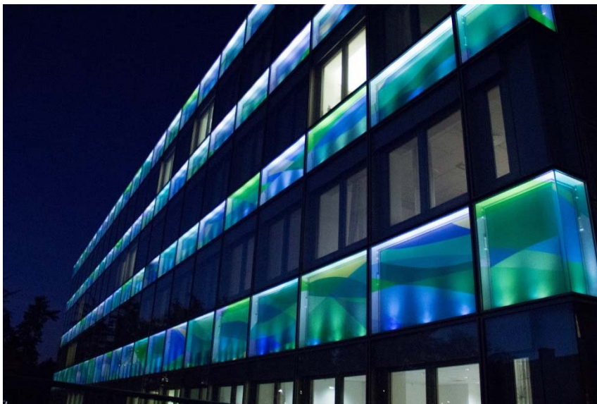
Exempelbild konst. Screentryckt glas och betong med inbyggd belysning. The color of water av Spencer Finch för Universitetssjukhuset i Linköping. Beställare Region Östergötland. Projektledning konst AM Public. Foto Johan Jäger.
