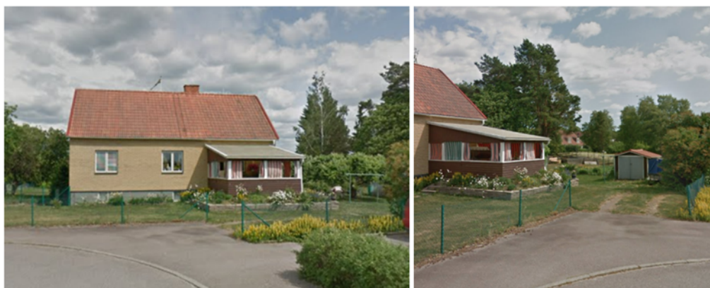
Figur 6 Byggnader inom fastigheten. Till vänster i bilden så syns huvudbyggnaden och i den högra så skymtas garagebyggnaden.
