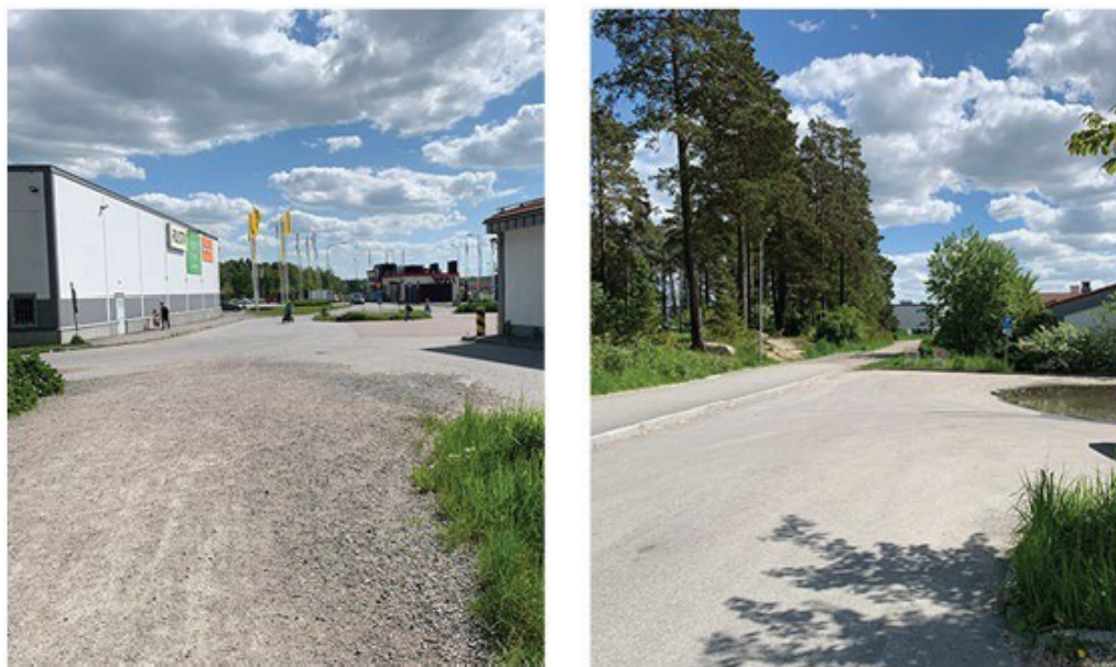
Figur 17: Bilden till vänster visar platsen där den befintliga gångbanan möter och övergår till angöringsvägen. Bilden visar dagens situation där gångvägen går längs med Stenskogen från Stenhagsvägen söderut (foto: Bjerking).
