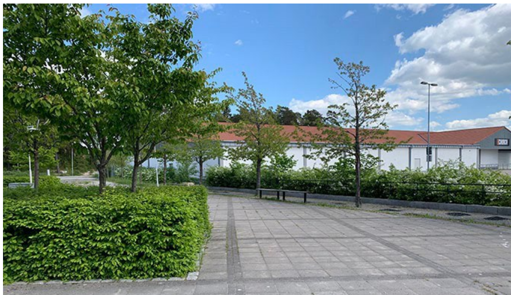
Figur 8: Vy mot den tidigare butikslokalen sedd från torgytan i nordväst (foto: Bjerking).
