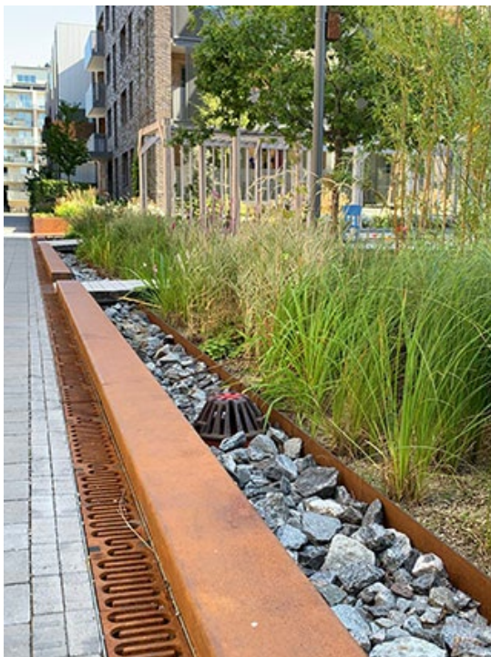
Figur 25: En upphöjd regnbädd som renar och fördröjer dagvatten i stadsmiljö (foto: Bjerking).
