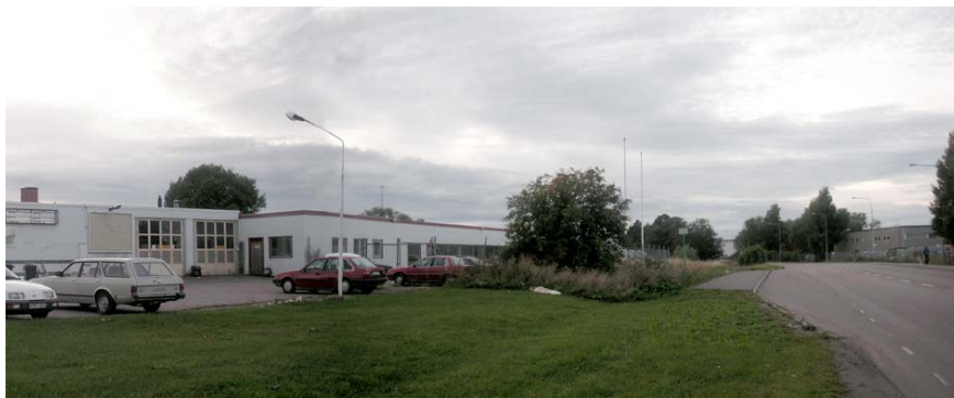
Befintliga byggnader inom planområdet. Vy längs Börjegatan i riktning mot nordväst.
