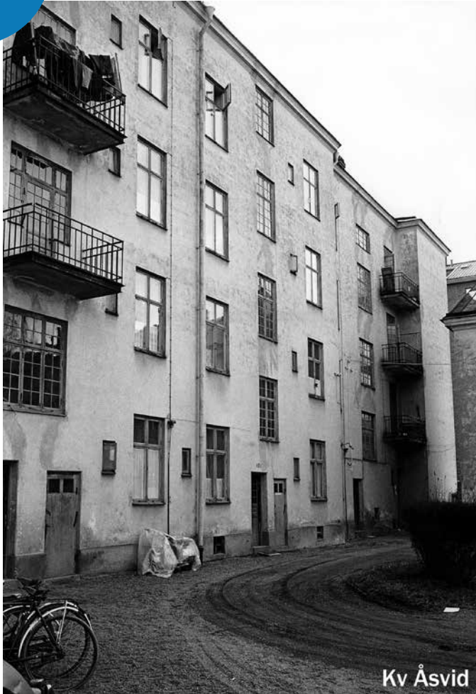
Gårdsmiljö i kvarteret Åsvid vid hörnet av Sysslomansgatan och Luthagesplanaden. Rivningsbeslut 1964. Foto: Sture Foto
