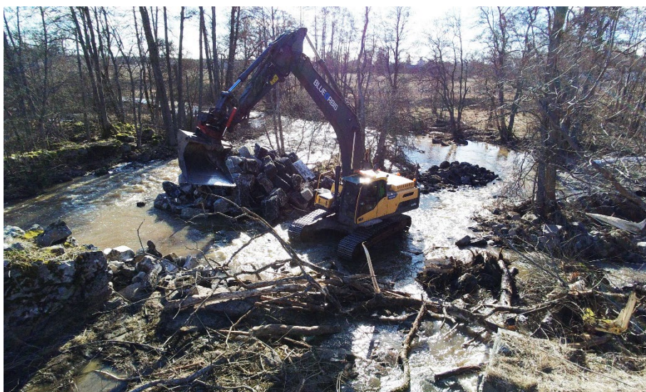
Utrivning av Herrkvarndammen som en del av åtgärdssamordningen för Sagån. Genom rivningen skapas fria vandringsvägar för fisk och vattenmiljön återställs. Foto: Viktor Kärvinge
