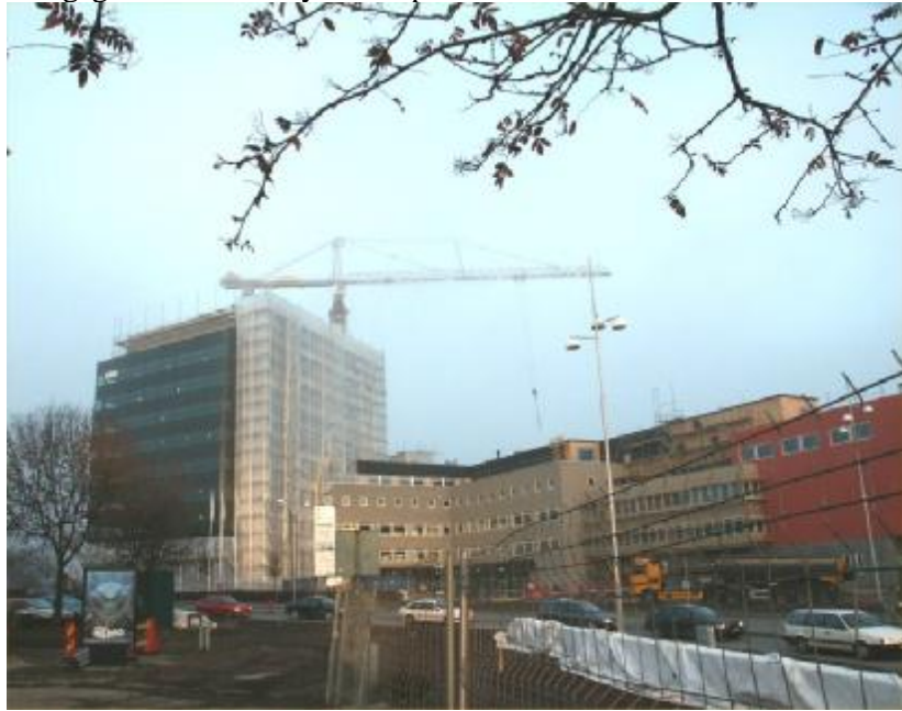
Det nya polishuset under uppförande
