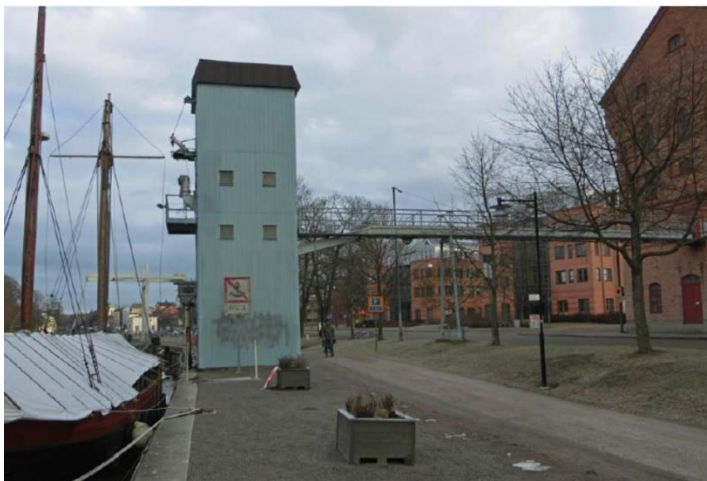
Skeppselevatorn. Foto Upplandsmuseet.
