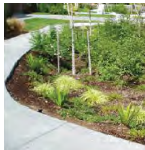
Exempel på en nedsänkt vegetationsbädd. Här kan dagvatten tas omhand och fördröjas (Gestaltningssprogram Ångkvarnen, 2019)
