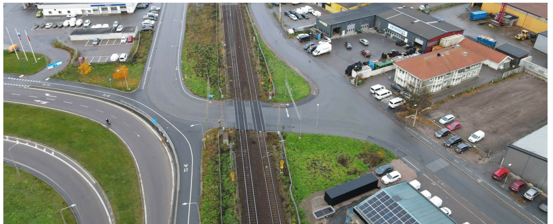
Figur 18. Befintlig plankorsning vid Vimpelgatan.
