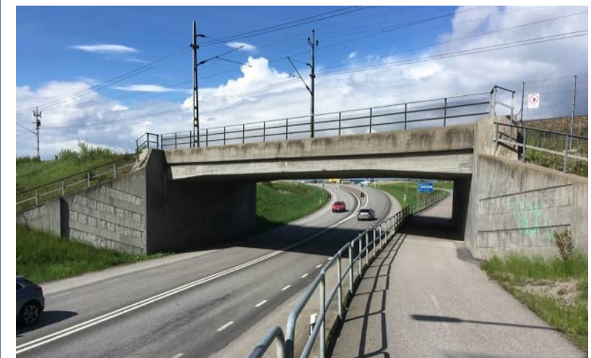
Figur 37. Bro över väg 255, vid Kuggebro.
