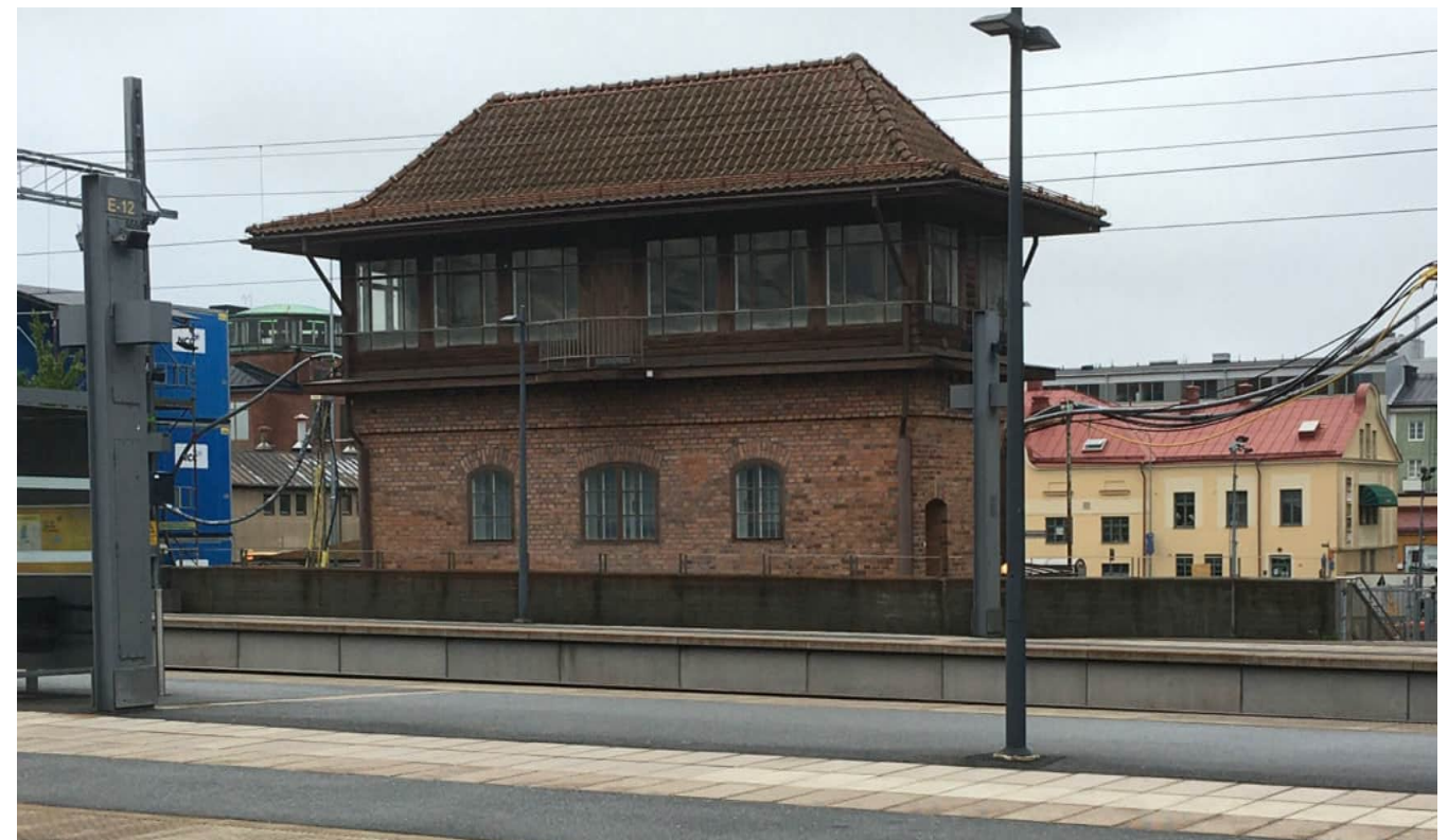
Figur 14. Ställverksbyggnaden från 1910-talet.
