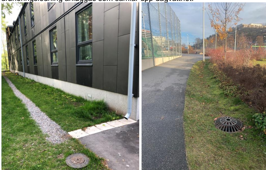
Figur 21. Exempelbilder på utvärdig avledning av takvatten via utkastare till makadamstråk (tv) samt avledning via grönt lågpunktsstråk (t.h.). Foton tagna av Bjerking AB.
