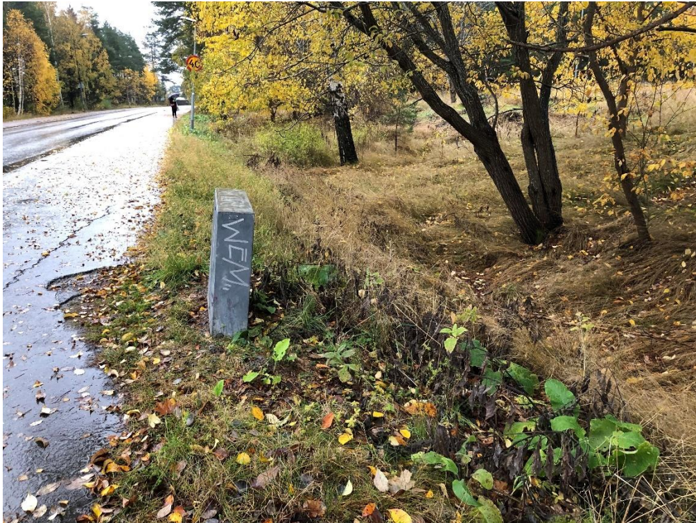
Figur 7. Befintligt dike längs med Skogsvägen.
