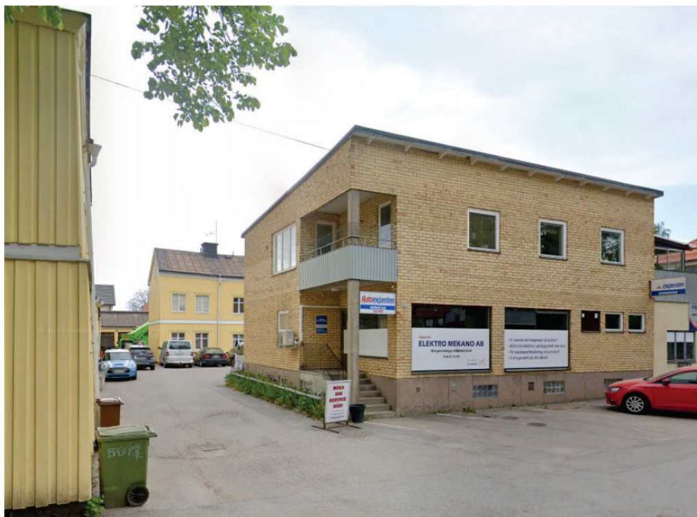
Figur 7 Bild från Timmermansgatan där man ser delar av de befintliga byggnaderna inom fastigheten.
