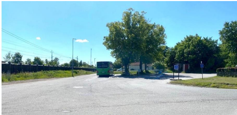
Figur 2: Väster om den befintliga järnvägsövergången.
