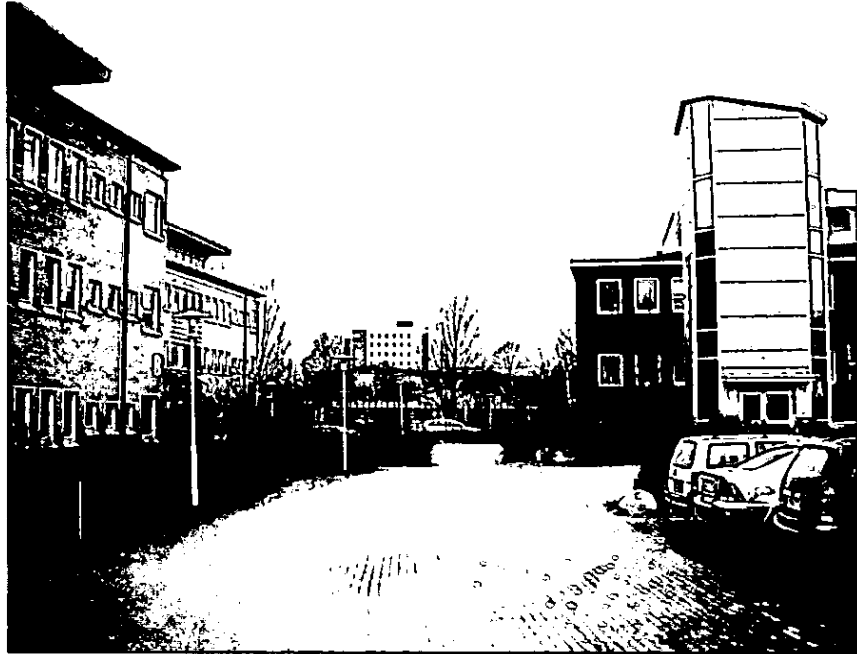
Gångväg som ansluter till gc-ståket längs järnvägsspåret.
