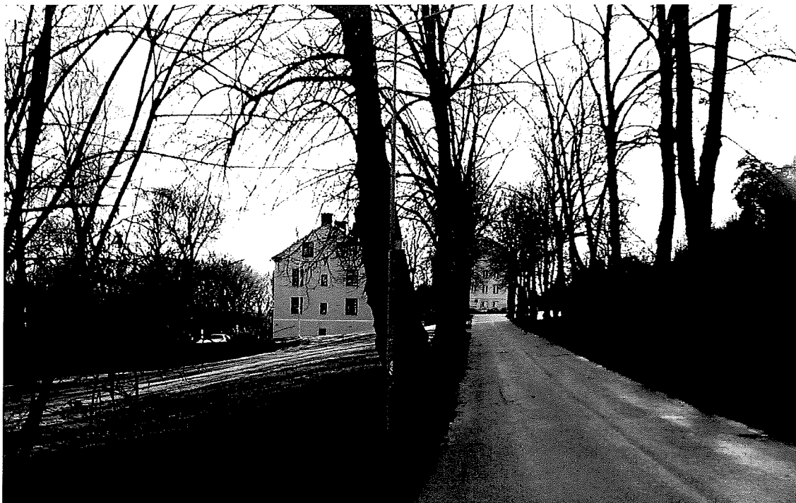
Kronobränneriets två kvarvarande byggnader vid Ulleråkersvägen.
