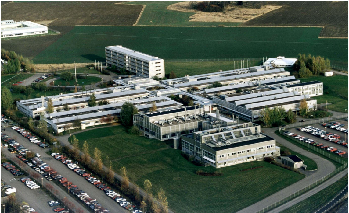
Figur 3. Översiktsbild över Phadiaz anläggning.
