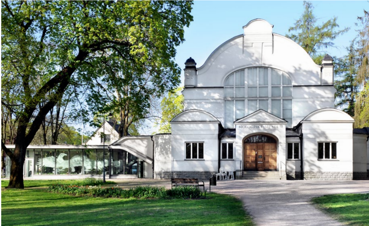
Biologiska muséet har byggts till med en modern entrédel som gör verksamheten mer tillgänglig och berikar parken.
