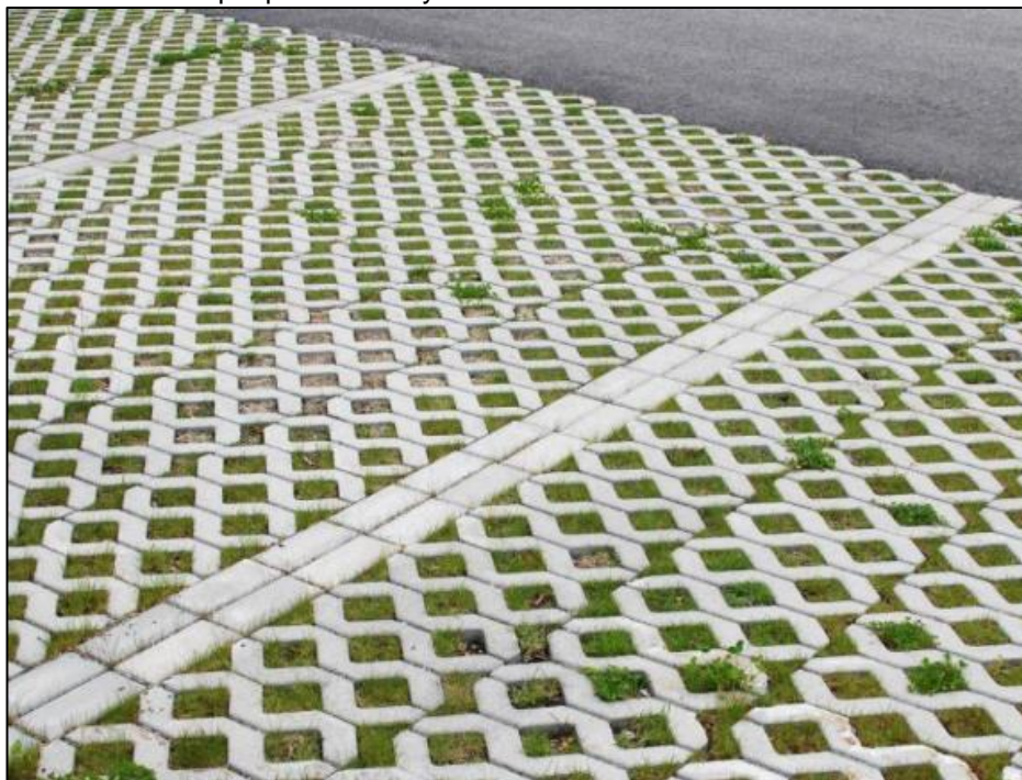
Figur 9. Rasteryta med gräs anlagd på parkeringsplats. Foto: Bjerking AB.
