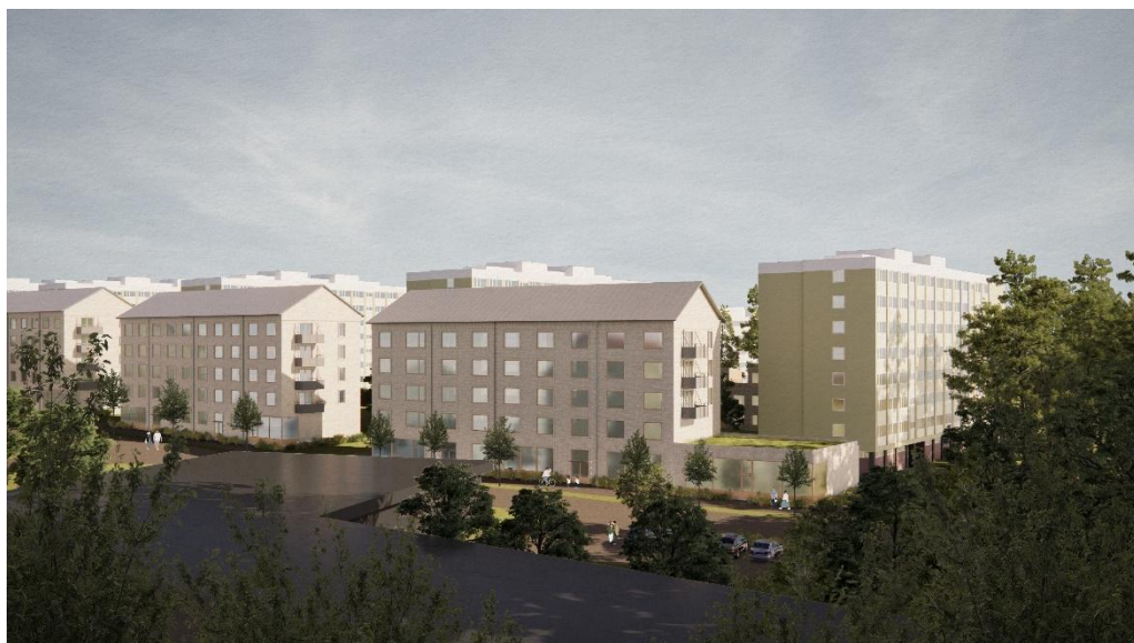
Figur 10. Bild av gatuhuset bland skivhusen, sedd från strax norr om Västertorg (bild: Kjellander Sjöberg).
