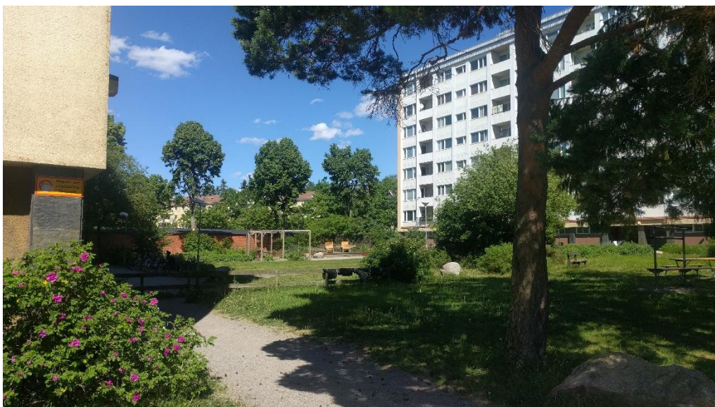
Figur 17. En av bostadsgårdarna på kvarteret Moränen, sett från parkstråket. Parken och gårdarna mellan skivhusen på kvarteret Moränen upplevs som en sammanhängande yta. Bilden togs juni 2018.
