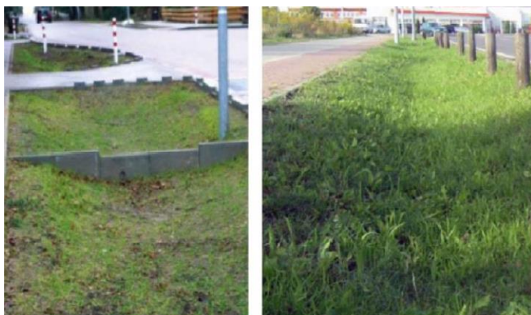
Figur 25. Exempel på hur gräsbeklädda diken kan utformas. Bilderna kommer från Stockholm Vatten och Avfall.
