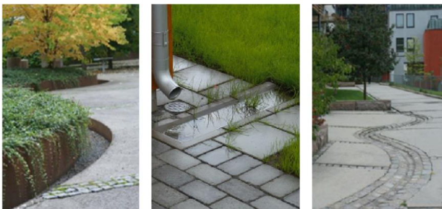
Figur 28. Exempel på utformning av dagvattenrännor i urban miljö. (Det högra och vänstra exemplet är foton från Sweco, exemplet i mitten kommer från S:t Eriks rännalsplattor)
